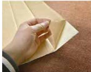
**Paso 3:** Retire el protector del adhesivo y proceda a pegar en la superficie presionando bien el muro 3D.
